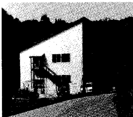
建設中の就労センター
