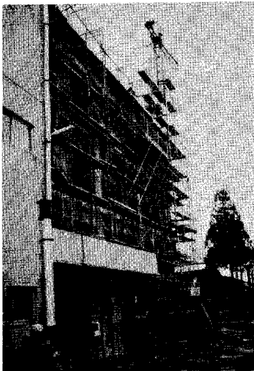
役場裏に建設が進む保健・活性化センター (12.21)
