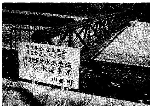
川辺地区の水管橋工事
