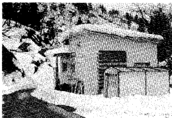
白倉地区簡易水道施設
