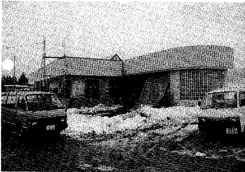
4月のオープンに向けて工事が進む老人サービスセンター
