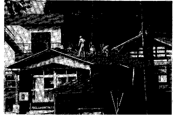
融雪式屋根の工事中のようす (中屋敷)
