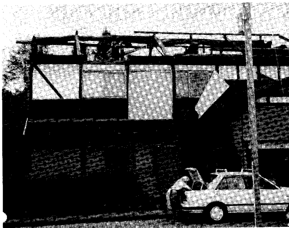
暴風で屋根が飛ばされた住宅（木落）
