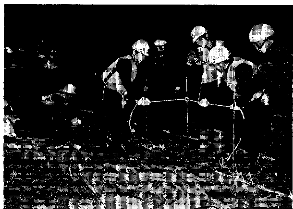
改良積み土のう工法に取り組む町消防団員
