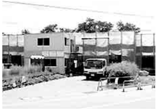
修繕工事が進む千手保育園
