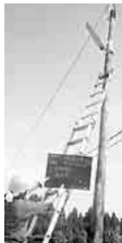
計画的に進められる街路灯の設置工事
