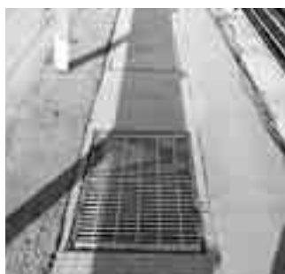
多くの歩道が流雪溝と同居しています
