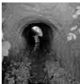
今も現役の水路トンネル
