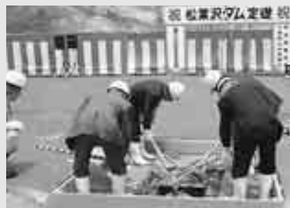
堤体中央部に鎮められた礎石
