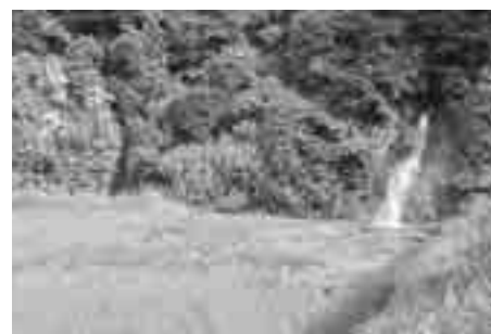
山腹から水が噴き出して土砂が流入した水田（星名新田地内）
