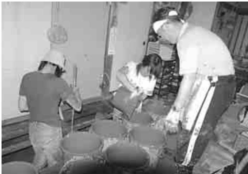
手作業で少しずつ泥をすくいます
