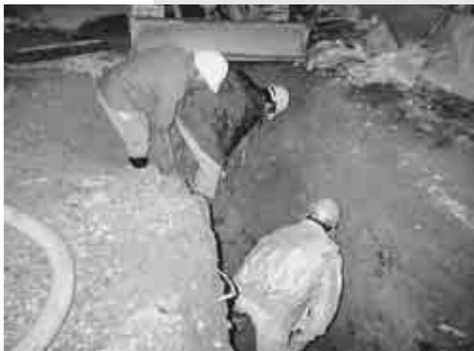
多くの労力を要する水道管の修理工事（管路掘削中）
