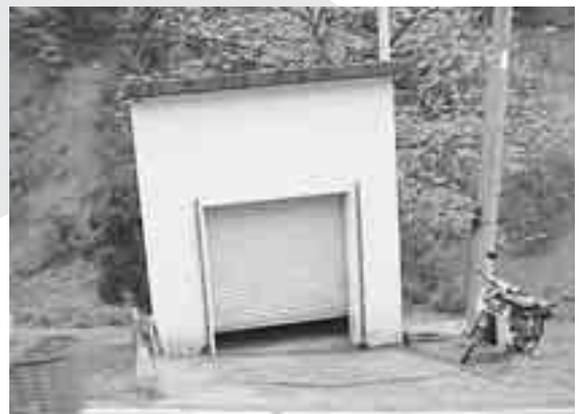
地盤沈下で傾いた中継ポンプ室（赤谷）
