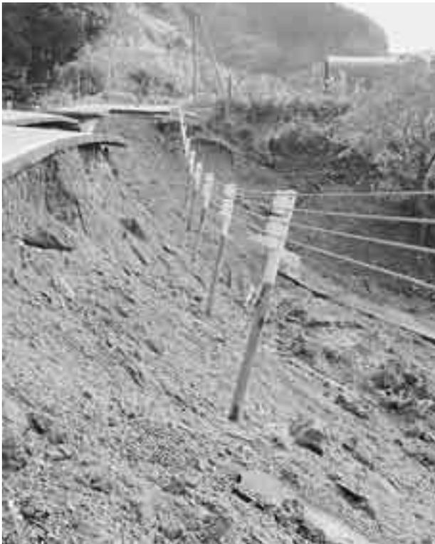
道路が欠落して、中吊りになったガードレール
