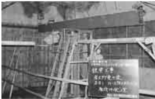
鉄骨梁で三階の床を補強している工事
