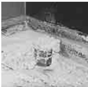
浮き上がった鉄骨柱の取付ボルト
