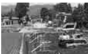
工事中の新十日町大橋関連道路
