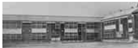
完成した橘小学校舎
