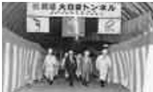
仮称大倉トンネル貫通
