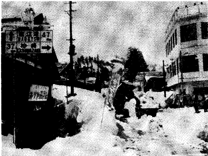
(写真[は]初[ま]つ[た]国[道]除[雪]状[況])
