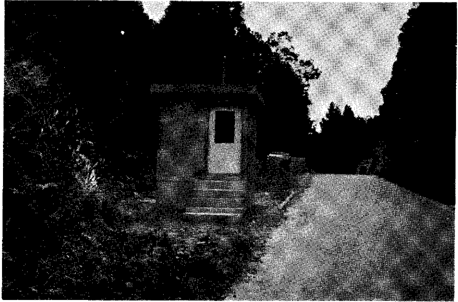
(完成した公衆便所第1号)
