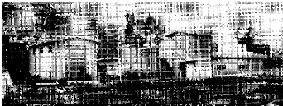
浄水場……室野にあります。
