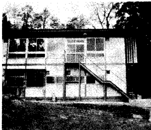
大伏集落開発センター建設費 1,322万円
