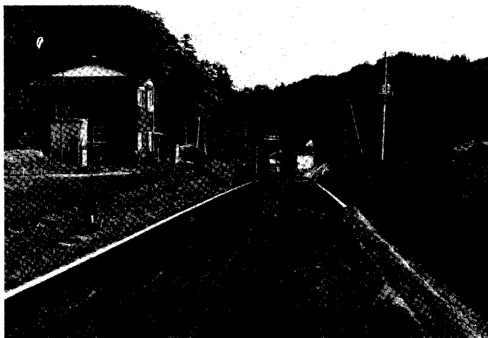
特改第4種事業（道路舗装工事）なる
