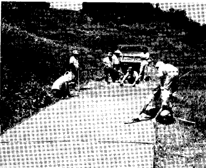
手づくり基盤整備
