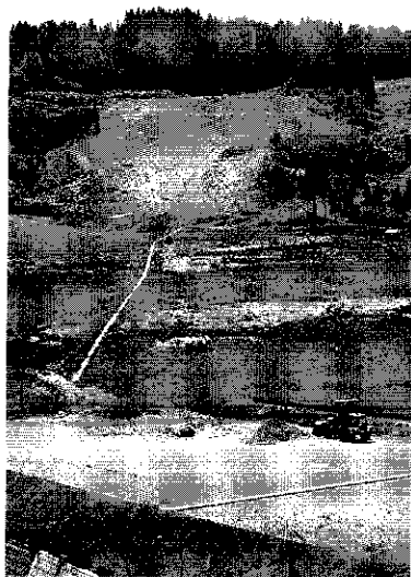
建設中のスキー場
