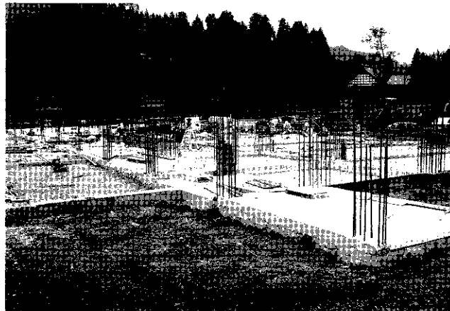
順調に工事の進むふるさと会館（9月29日現在基礎工事が行なわれていた）
