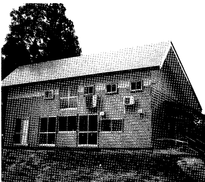
▲完成した蒲生小規模デイサービスセンター 正面には、駐車場も完備しています。
