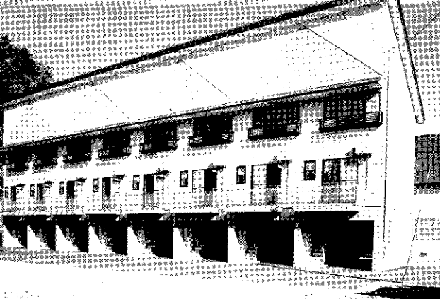
▲完成した「ゆきつばき荘」 住宅の裏はJAしづみ農協倉庫
