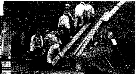
▲6月27日国道253号線改良工事で壊される千年の 道の石段を室野城山保存会が再利用のため搬出。
