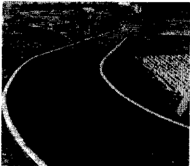
松代松之山線舗装(観音寺地内)
