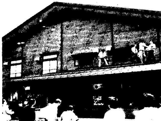
棟梁の手によって祝いのモチまきも行われた竣工式。スナックと理・美容室が併設されています
