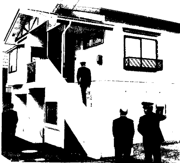
雪掘りの心配がなくなった 新松之山駐在所
