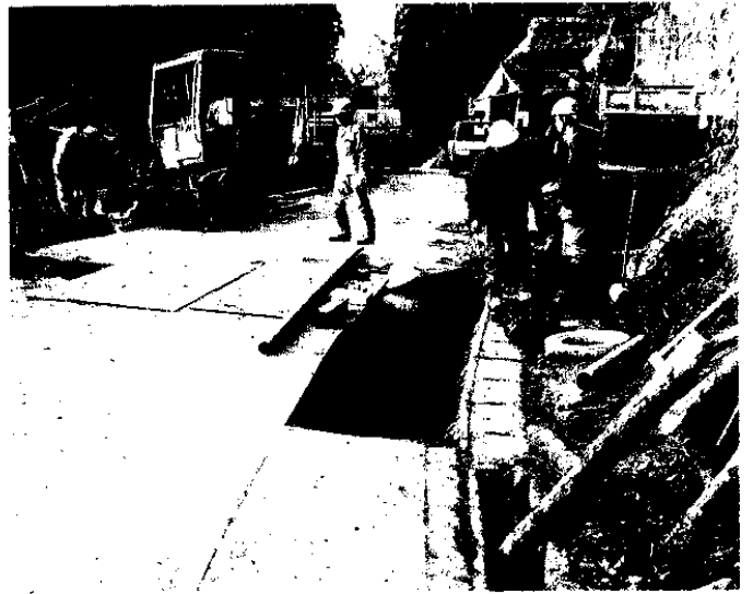
工事が進む上級池簡易水道
