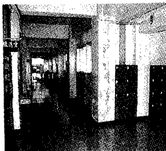
内装工事が行われる松中
