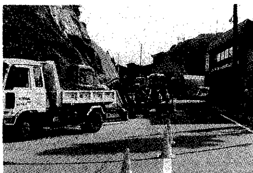
県道の下水道管布設工事が始まりました
