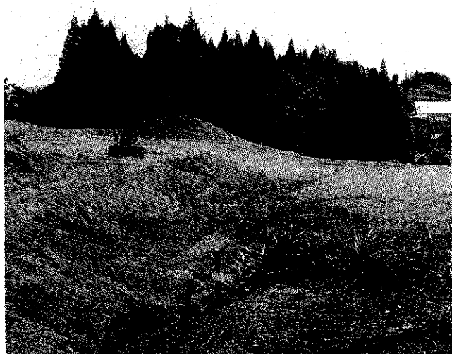
現在、宅地造成工事が進んでいます
