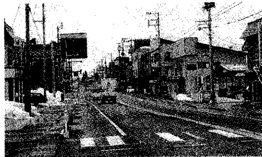
すっかり整備された国道117号役場前付近より
