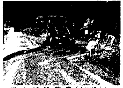
進む道路整備(小出地内)
