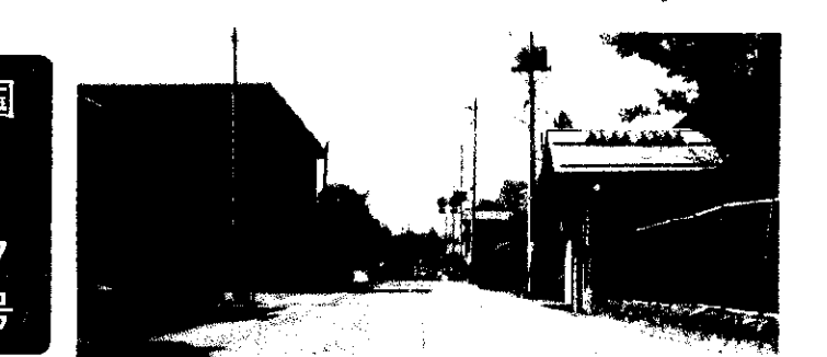
改良が始まる第三工区
