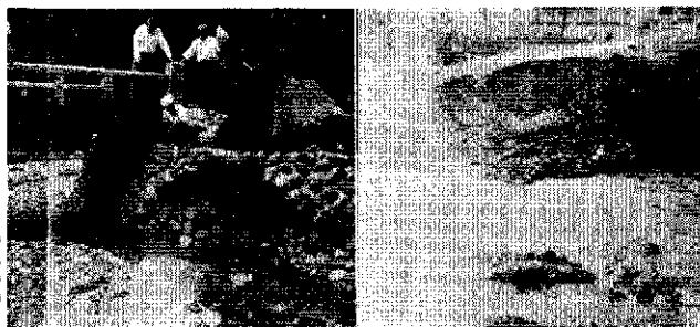
小貫橋右岸橋台沈下 水上橋流失のあと
