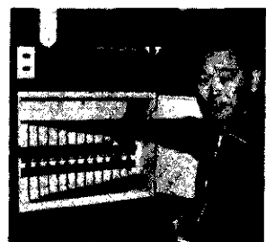
配電板は家の中に
