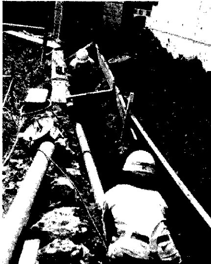
つなぎ込み工事の始まった松井さん宅(稲荷町)
