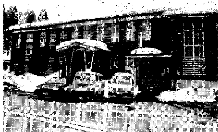
改築される水沢地区公民館
