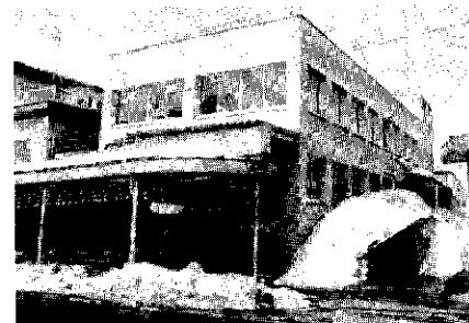
郵便局跡地に立体駐車場を建設
