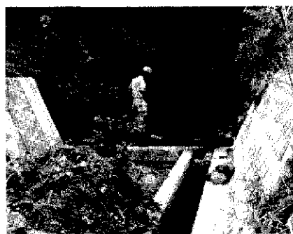
完了した高島地内の用水路
