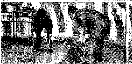
6月14日、鑑島小学校建設工事の起工式が行われました。来年3月には鉄筋コンクリート造3階建ての新校舎が完成します。
