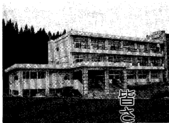
校舎と給食室が新しく完成し、6月10日に竣工式が行われた鐘島小学校
