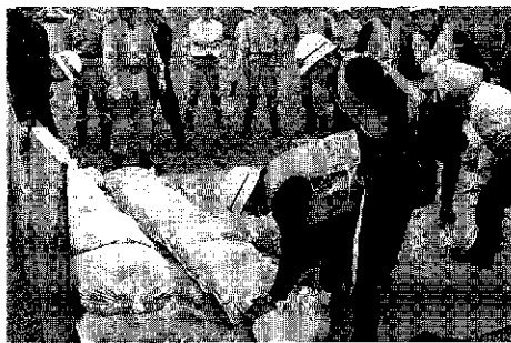
積み土のう工法に励む消防団員
