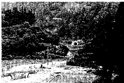
鉢沢横坑(写真中央)からの湧水が、ため池に貯留され揚水されます。
