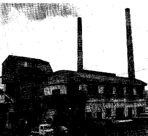
力も大幅に機能アップされます。また、機械集じん方式、有害ガス除去装置、クローズシステムなど最新の公害防止装置を備えています。さらに、美観を配慮した施設は、機械化、自動化を図り、コンピュータを利用して集中管理方式を取り入れ、必要最少人員で運転管理することができ、清掃工場となります。
