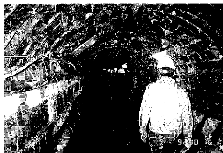
鍋立山トンネル貫通まで約2.5kmまで掘り進んだ中央導坑内
