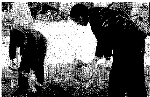
市長と施工業者代表が緞入れをしました
