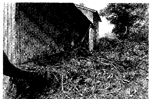
【小泉地区内】 裏手の崖が崩れ、土砂と一緒に立木が車庫に突き当たる。
