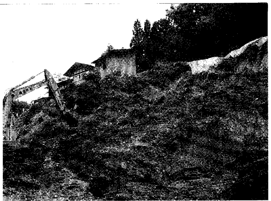
【鉢地内】 11日夜から土砂崩れの前兆あり。12日朝、ついに崩れ、県道・真田高島線を土砂が覆いつくす。付近の3世帯が自主避難する。
