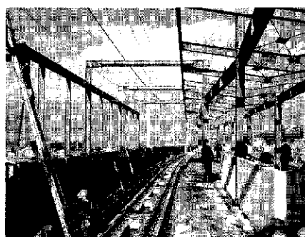
建設が進む十日町駅ホーム（左側が防風壁）
